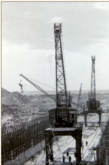
Портальные краны на сооружении одного из шлюзов канала.
