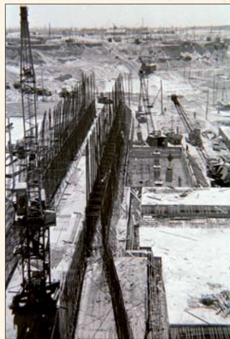
Сооружение рыбоподъемника на Цимлянском гидроузле.
